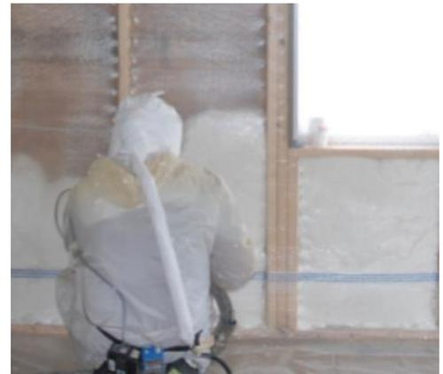
**Esté atento a la expansión y retracción de la espuma. Si no hay retracción después de dos minutos, ajuste las temperaturas de pulverización 5°F hacia arriba. Si la espuma no retrocede hacia la cavidad de la pared o no está alineada con los montantes, presione la espuma con la palma de la mano mientras aún esté caliente (dentro de los 3 minutos).**
